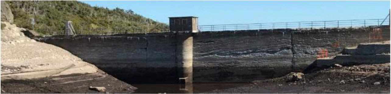
Figure 34: Vue d'ensemble du parement amont du barrage (Source : Reconstruction du barrage de la Vigie – Phase 1 – Rapport de diagnostic. ARTELIA, 2021)
